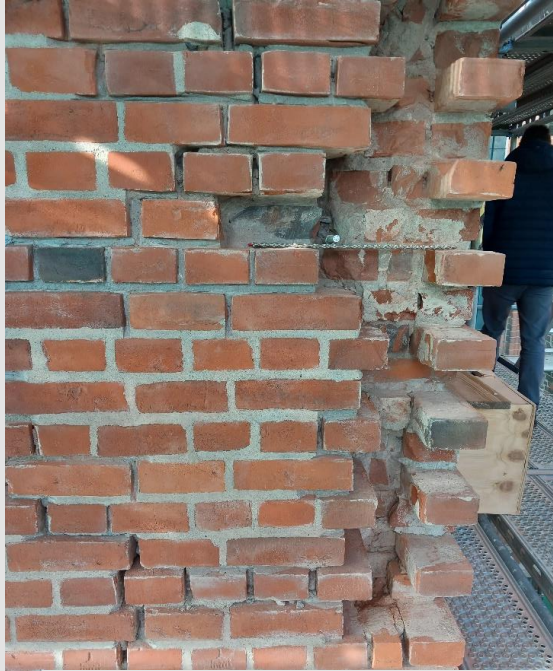
Schadensbild Mauerwerk außen. Beschädigte Steine wurden entfernt.
