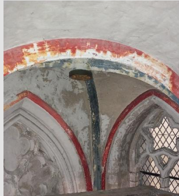
Schadensbild Wandoberfläche innen. Schäden u.a. verursacht durch Feuchte- und Salzbelastung. Links vorher, rechts nachher
